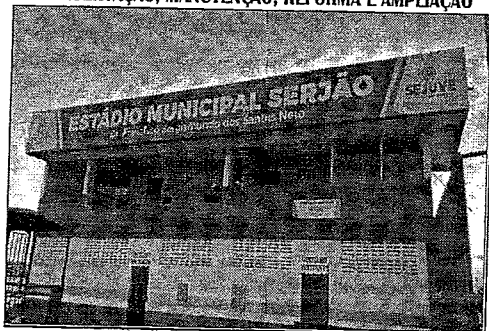
CONSERVAÇÃO, MANUTENÇÃO, REFORMA E AMPLIAÇÃO
