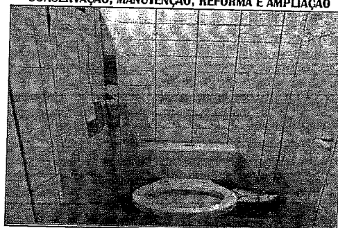
CONSERVAÇÃO, MANUTENÇÃO, REFORMA E AMPLIAÇÃO
