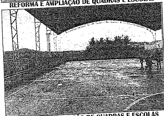
REFORMA E AMPLIAÇÃO DE QUADRAS E ESCOLAS
