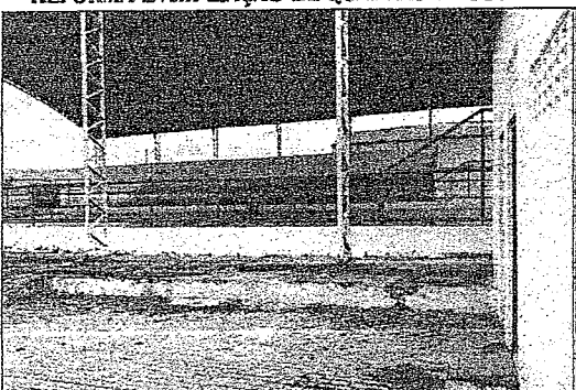
REFORMA E AMPLIAÇÃO DE QUADRAS E ESCOLAS
