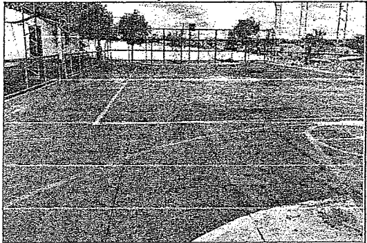
REFORMA E AMPLIAÇÃO DE QUADRAS E ESCOLAS
