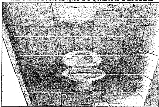
REFORMA E AMPLIAÇÃO DE QUADRAS E ESCOLAS
