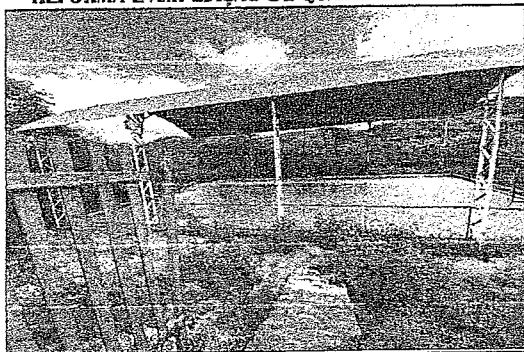
REFORMA E AMPLIAÇÃO DE QUADRAS E ESCOLAS
