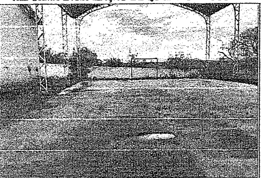
REFORMA E AMPLIAÇÃO DE QUADRAS E ESCOLAS
