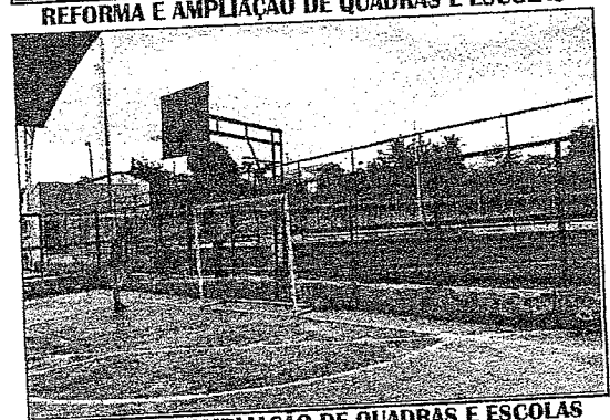
REFORMA E AMPLIAÇÃO DE QUADRAS E ESCOLAS
