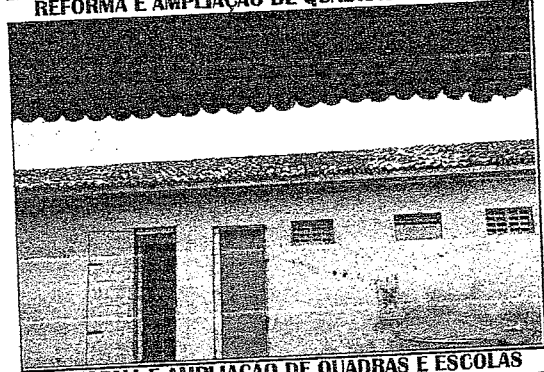
REFORMA E AMPLIAÇÃO DE QUADRAS E ESCOLAS
