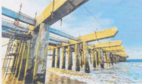
REFORMA da Ponte dos Ingleses ainda está na primeira fase |
