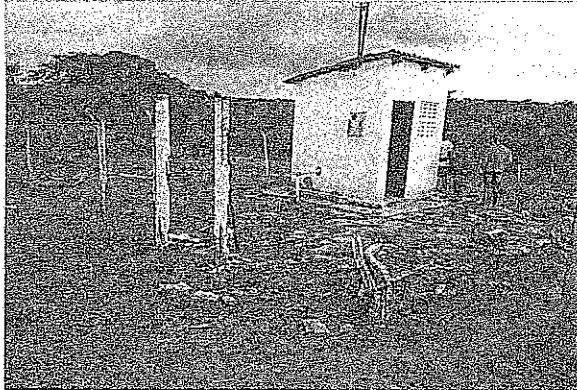
CAIXA D'ÁGUA - LOCALIDADE TABULEIRO ALEGRE
