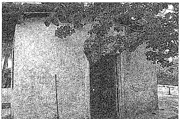
CAIXA D'ÁGUA - DISTRITO IBUAÇU
