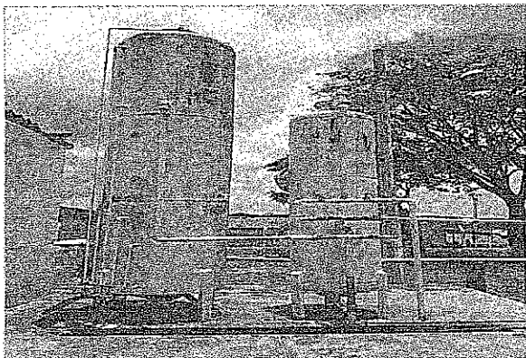
CAIXA D'ÁGUA - DISTRITO ÁGUAS BELA
