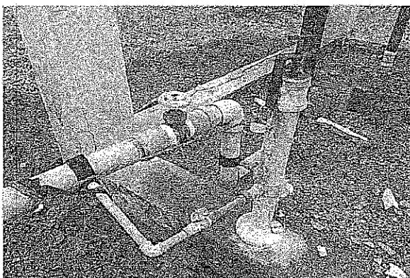
CAIXA D'ÁGUA - DISTRITO ÁGUAS BELA
