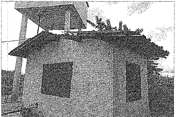
CAIXA D'ÁGUA - DISTRITO IBUAÇU
