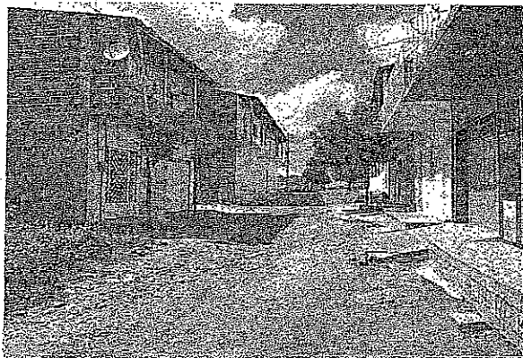
RUA PROJETADA C - BAIRRO DE FÁTIMA
