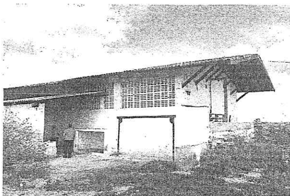
ÁREA EXTERNA - PINTURA DA FACHADA E PROLONGAMENTO DA COBERTA.
