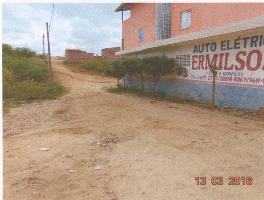
Figura 1—Início da Rua Antônio de Assis Uchôa
