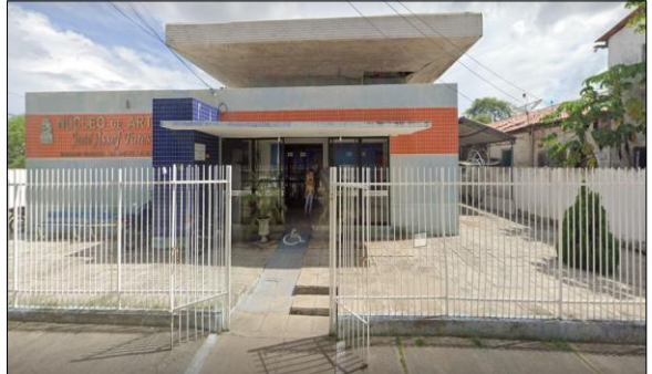
ESPAÇO PARA A REFORMA E AMPLIAÇÃO (CONSTRUÇÃO DE DUAS SALAS) NO NÚCLEO DE ARTES E CULTURA (NAEC) JOSÉ ASSEF FARES.
