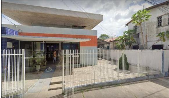
ESPAÇO PARA A REFORMA E AMPLIAÇÃO (CONSTRUÇÃO DE DUAS SALAS) NO NÚCLEO DE ARTES E CULTURA (NAEC) JOSÉ ASSEF FARES.
