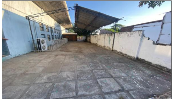
ESPAÇO PARA A REFORMA E AMPLIAÇÃO (CONSTRUÇÃO DE DUAS SALAS) NO NÚCLEO DE ARTES E CULTURA (NAEC) JOSÉ ASSEF FARES.
