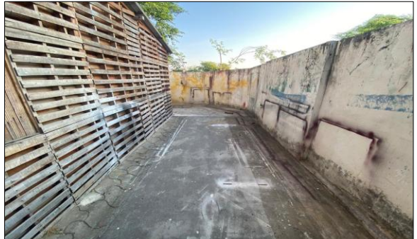
ESPAÇO PARA A REFORMA E AMPLIAÇÃO (CONSTRUÇÃO DE DUAS SALAS) NO NÚCLEO DE ARTES E CULTURA (NAEC) JOSÉ ASSEF FARES.
