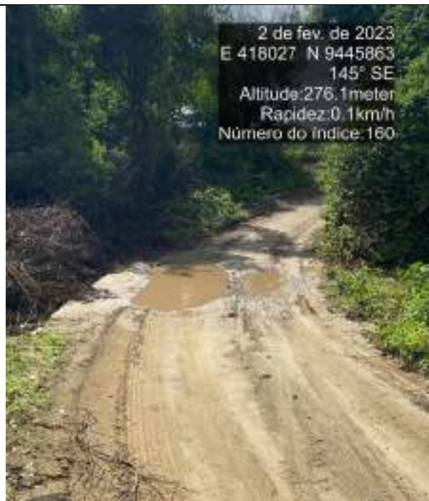
FIGURA 4 - PASSAGEM MOLHADA IV - EM LEITO NATURAL
