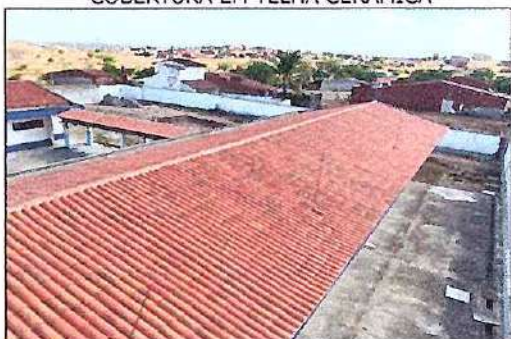
COBERTURA EM TELHA CERÂMICA
