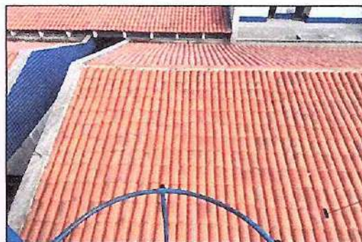
COBERTURA EM TELHA CERÂMICA
