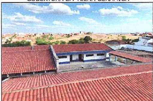
COBERTURA EM TELHA CERÂMICA
