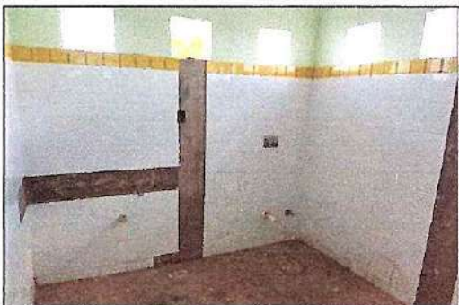
CERÂMICA E INSTALAÇÕES HIDRAULICAS
