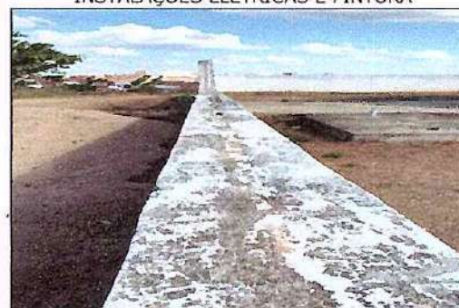
GRADE DA DO MURO DA FRENTE
